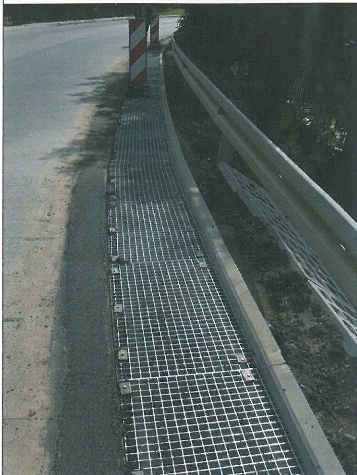
Fot. 3. Kolektor otwarty przy krawędzi ul. A. Mickiewicza, wykonany w 2010 r. Poniżej działki 241/1 oraz 242/1.
