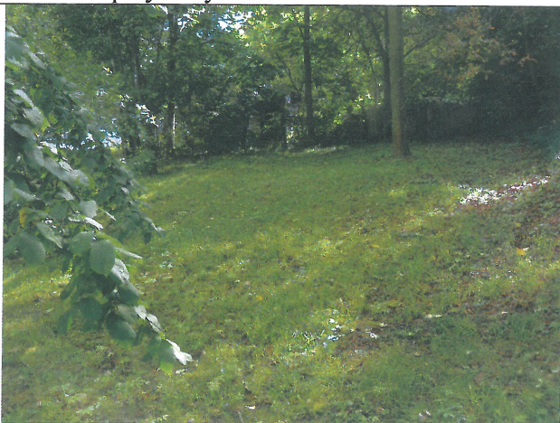
Czoło koluwiów w centralnej części osuwiska
