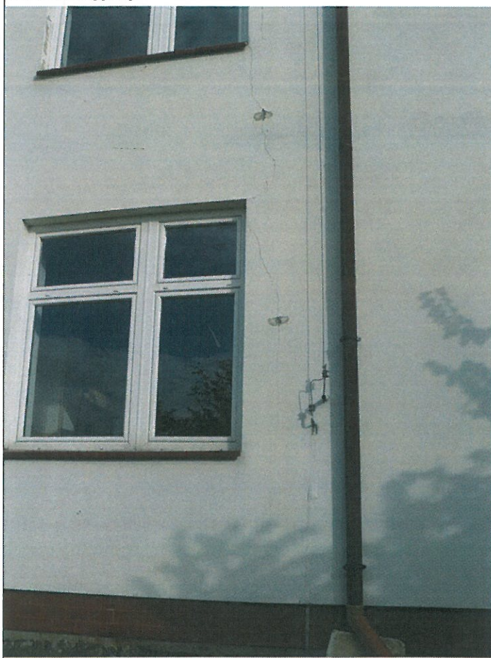
Fot. 6. Spękania murów szkoły przy ul. Dworskiej; wodoczny ślad po założonej szklanej plombie obserwacyjnej.
