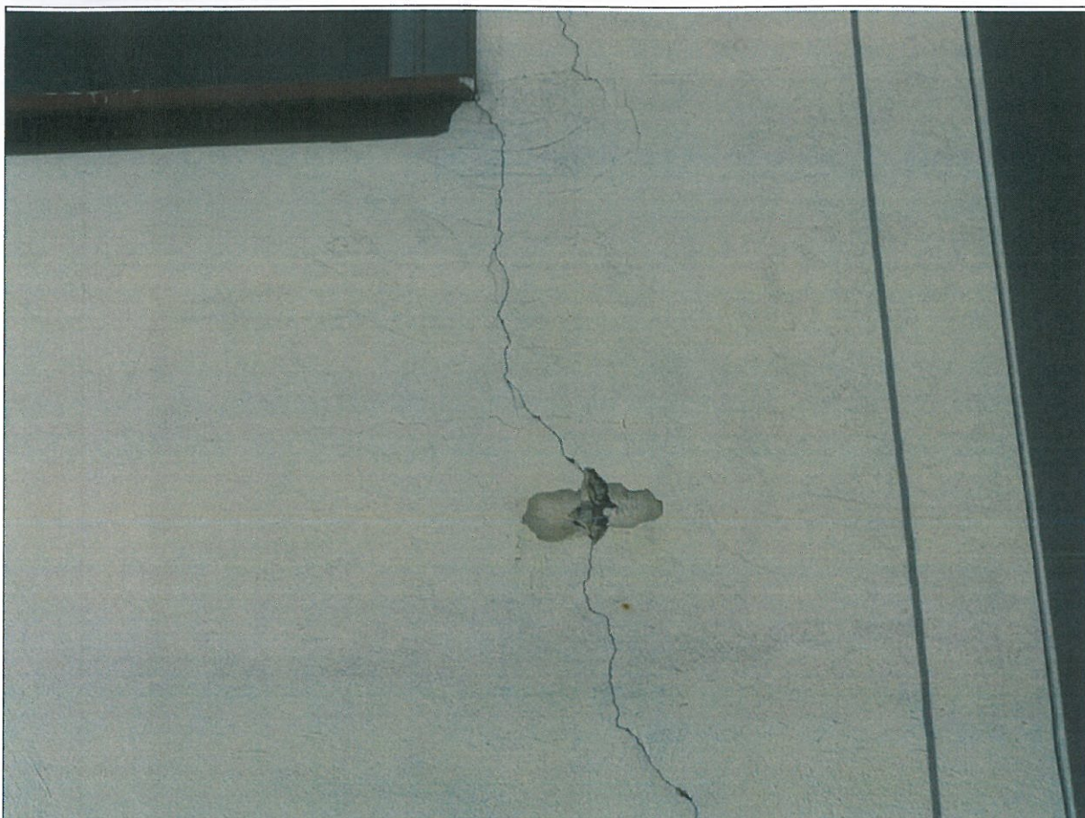
Fot. 6. Spękania murów szkoły przy ul. Dworskiej; wodoczny ślad po założonej szklanej plombie obserwacyjnej.
