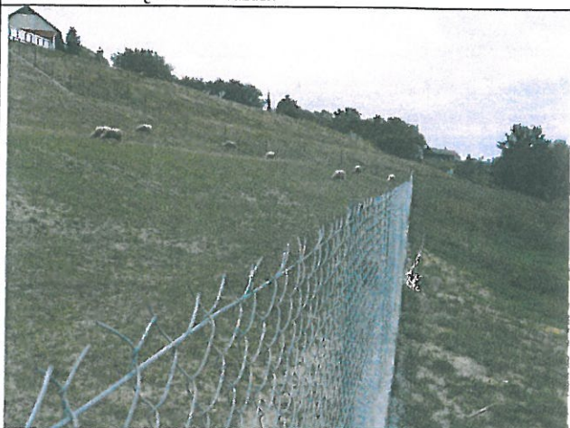
Zabezpieczony fragment osuwiska (palisady, drenaże, przykryte warstwą humusu)
