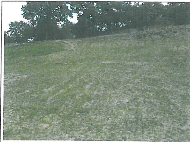
Północna część osuwiska
